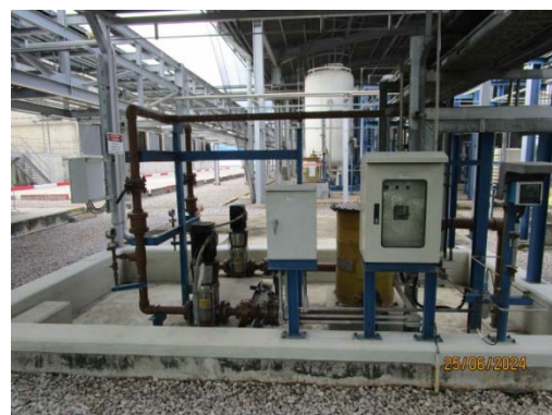
รูปที่ 8 ป่อปรับสภาพน้ำปนเปื้อนสารเคมีด้วยกรด-ด่าง
