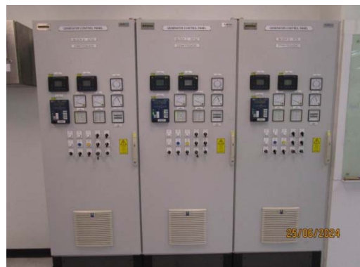
รูปที่ 53 ระบบป้องกันทางไฟฟ้า (Relay) ที่เครื่องกำเนิดไฟฟ้า
