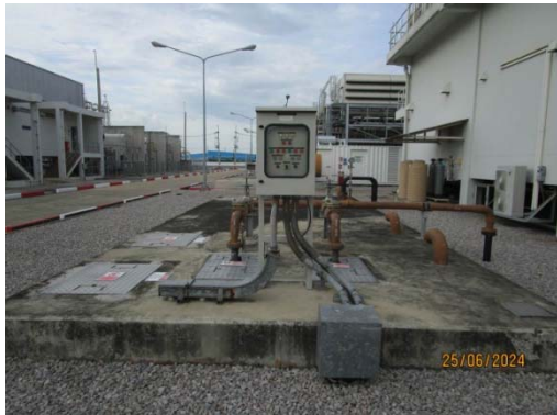
รูปที่ 5 ป่อแยกน้ำ-น้ำมัน (Oil/ Water Separator)
